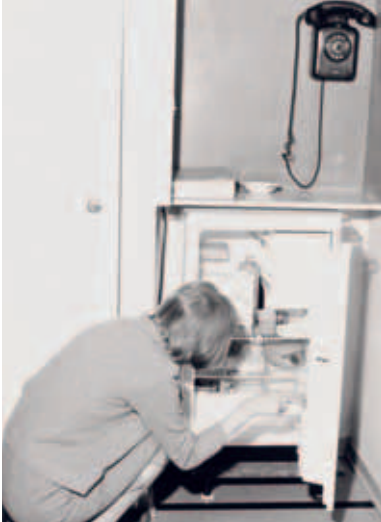
Kerroksen asukkaiden yhteinen puhelin ja jääkaappi olivat käytävässä.
