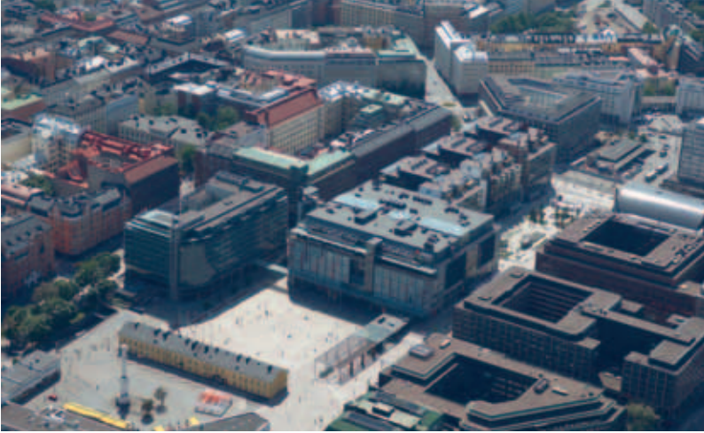
Kampin uusi kauppakeskus kesällä 2006. Hämmäläinen talo on piilossa kauppakeskuksen takana. Kuva SRV Oyj.
