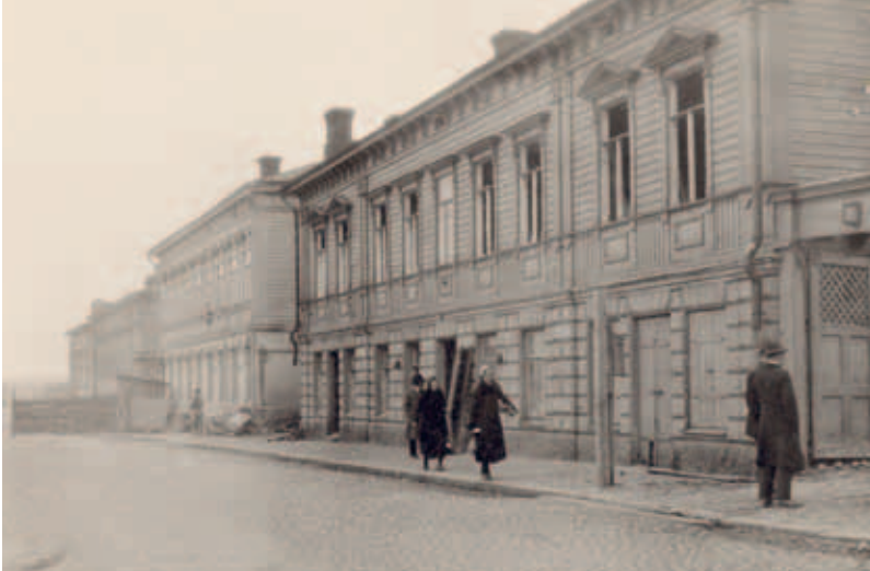
Kampinkatu 4 ja 6 ennen purkutöiden alkua.
